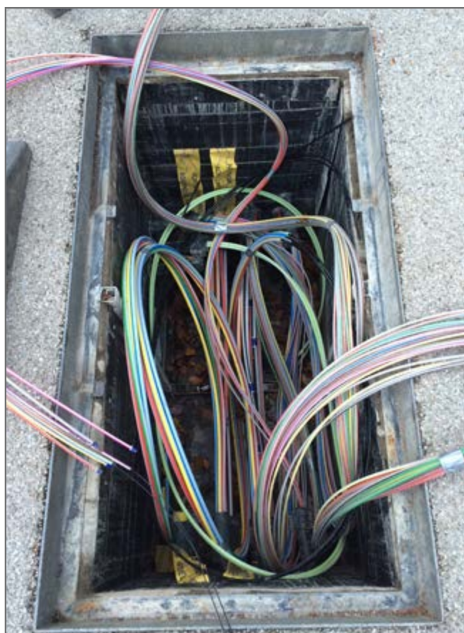
Zabudowana studnia z różnymi rodzajami okablowania
