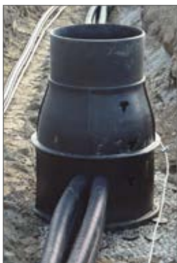
Budowa drogi komunalnej
