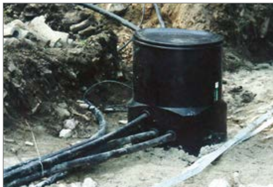
Zarząd Lasów: wymaganie całkowicie szczelnych studni kablowych dla instalacji wzdłuż leśnych dróg.
