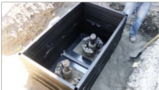
ROM-Box do armatury przesyłowej w sieciach ciepłowniczych.
