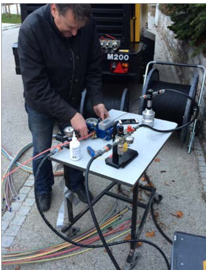
Kable będą wdmuchiwane
