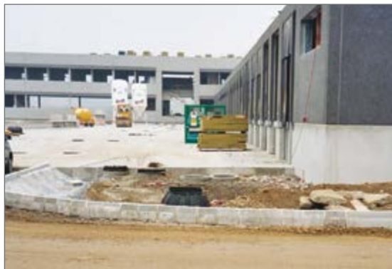
ALDI Centralny Magazyn: okablowanie dla oświetlenia.
