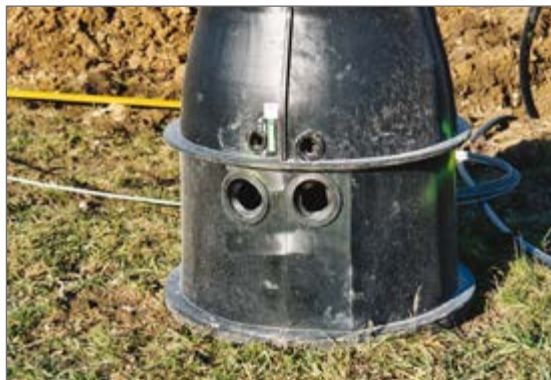
Przyłączenie każdej rury w dowolnym miejscu z uszczelką ROMOLD Typ IS.
