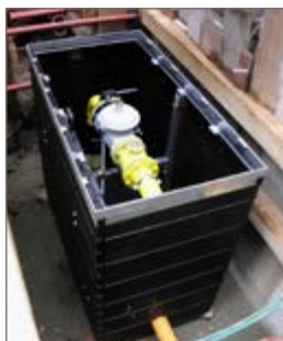
ROM-Box do prefabrykowanego zestawu armatury gazowej.
