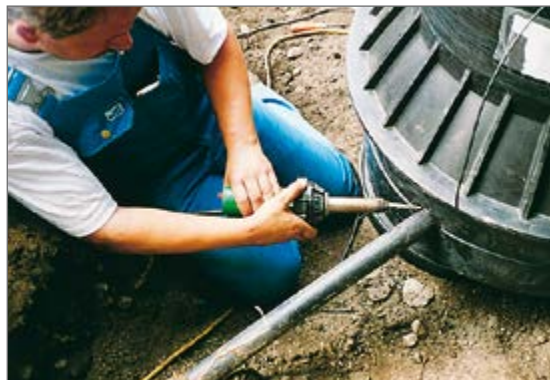
Energia AG Austria: spawanie elementów
